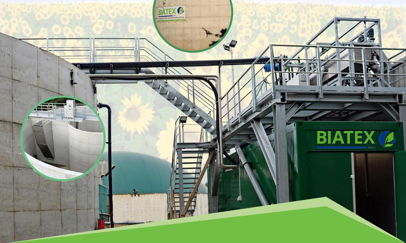
Im ersten Schritt erfolgt die zweistufige Separation zur Abrennung der Feststoffe. Die flüssige Phase wird dann in das Biologiebecken geleitet, in dem die Sedimentation, Nitrifikation und Denitrifikation stattfindet.
