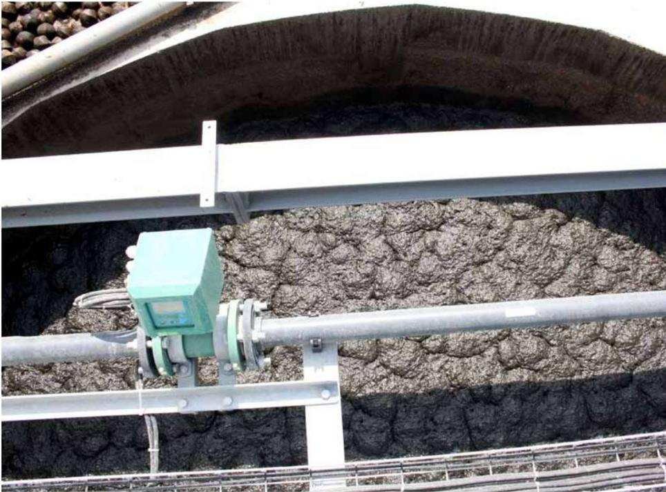
Blick von oben in den Vorlagebehälter mit der fertig separierten Flüssigkeit. Aus diesem Behälter wird das Belebungsbecken gespeist.
