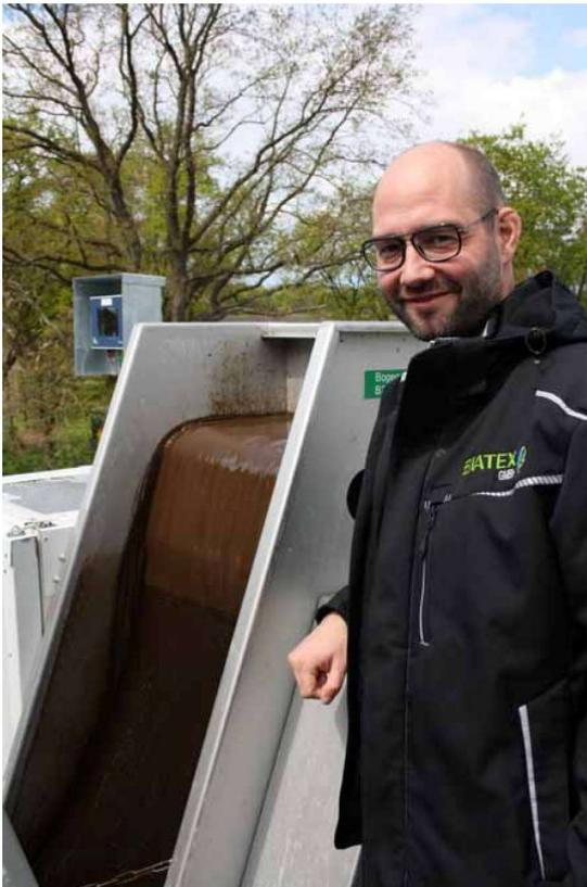
Daniel Kollmann am Bogensieb, das vor dem Ablauf der fertig behandelten Flüssigkeit die enthaltenen Anamoxbakterien zu einem Großteil zurückhalten soll. Das vom Bogensieb abgetrennte Material fließt zurück ins Anamoxbecken, der größere Rest wird ins Gärdüngerlager gepumpt.
